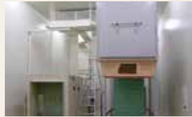
اختبار تدفق الهواء Airflow testing
